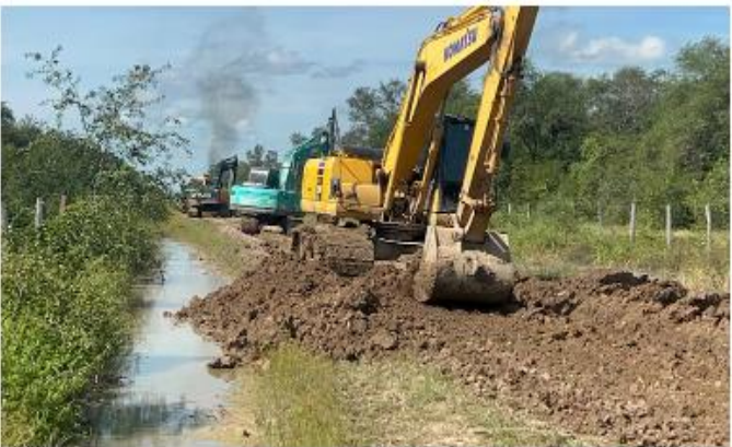
Productores de la zona de María Auxiliadora logran reparar sus caminos privados, permitiendo de esta forma que más de 2.500 pobladores tengan posibilidad de salir del aislamiento.
