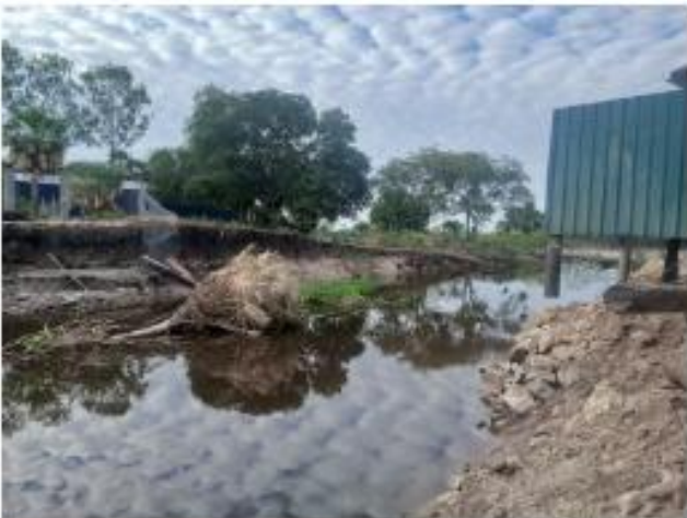
Al bajar el nivel natural de las aguas, la tierra de la zona muestra toda la gran destrucción a los pocos metros tras salir de Fuerte Olimpo.
